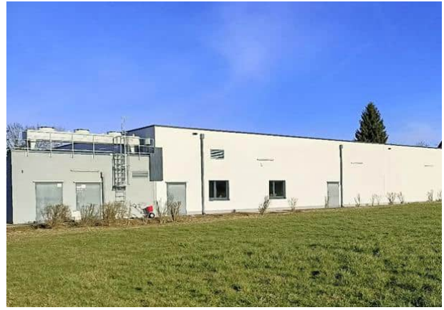
Abbildung 11: Blick auf die zu erweiternde Südostseite des Gebäudes
